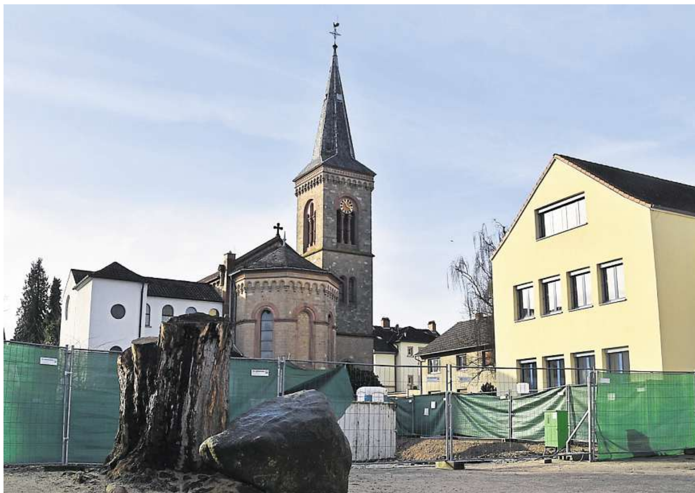
Im März soll der Spatenstich für den Erweiterungsbau der Grundschule in der Ortsmitte von Einhausen erfolgen. Im Zuge der Erweiterung wird auch eine neue Mehrzweckhalle errichtet, die von Schule und Gemeinde gemeinsam genutzt wird. Foto: Hans-Jürgen Brunnengräber
